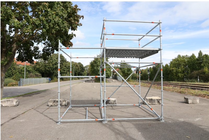
Abbildung 10: Übungsgerüst mit 1. OG
