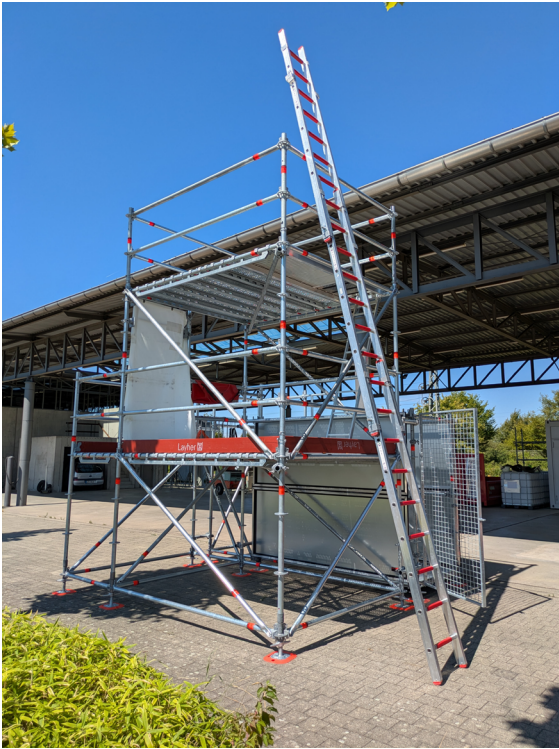
Abbildung 9: Beispiel Anleitern an einem Übungsgerüst
