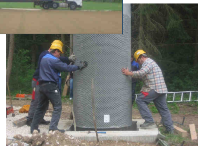
Anlieferung mit dem Tieflader / Alles im Lot
