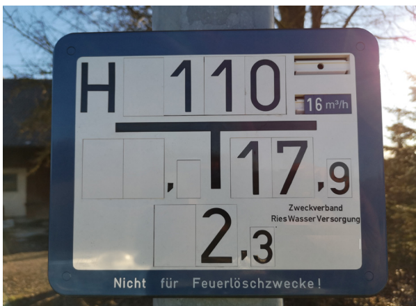
Abbildung 10: Nach der Faustformel müsste dieser Unterflurhydrant 1100 l/min liefern. Tatsächlich liefert er 16 m 3 pro Stunde, umgerechnet also nur 266 l/min!
