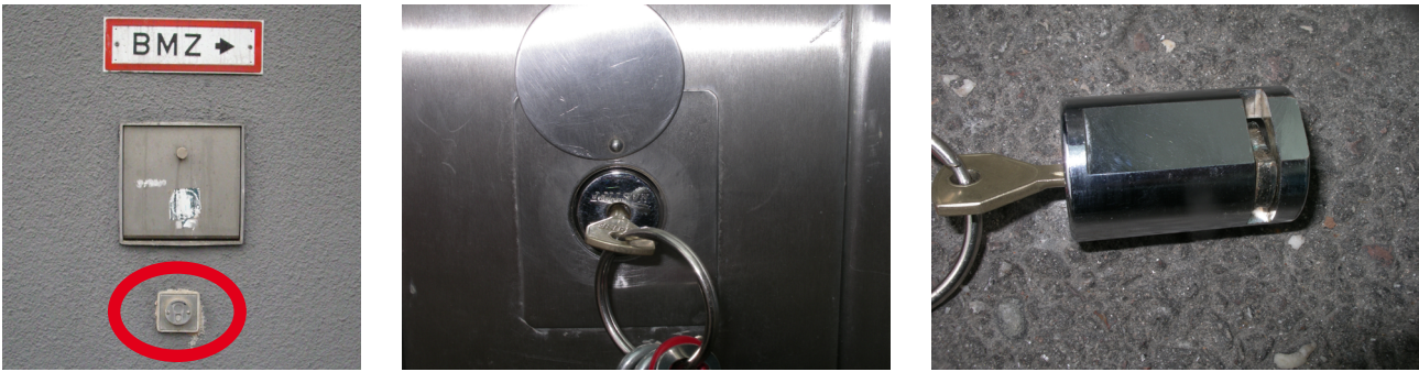
Abbildung 10: Links: Lage des FSD, Mitte: geöffnete Klappe, rechts: entnommener Stahlzylinder
