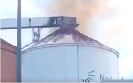
Video: Einsturz eines Silodaches durch Brandeinwirkung
