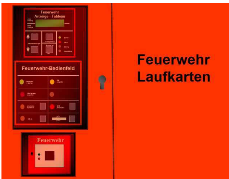
ABBILDUNG 8: BEISPIELHAFT FEUERWEHRINFORMATIONSZENTRALE
