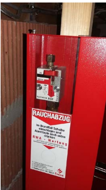
ABBILDUNG 16: MANUELLE AUSLÖSESTELLE FÜR RWA
