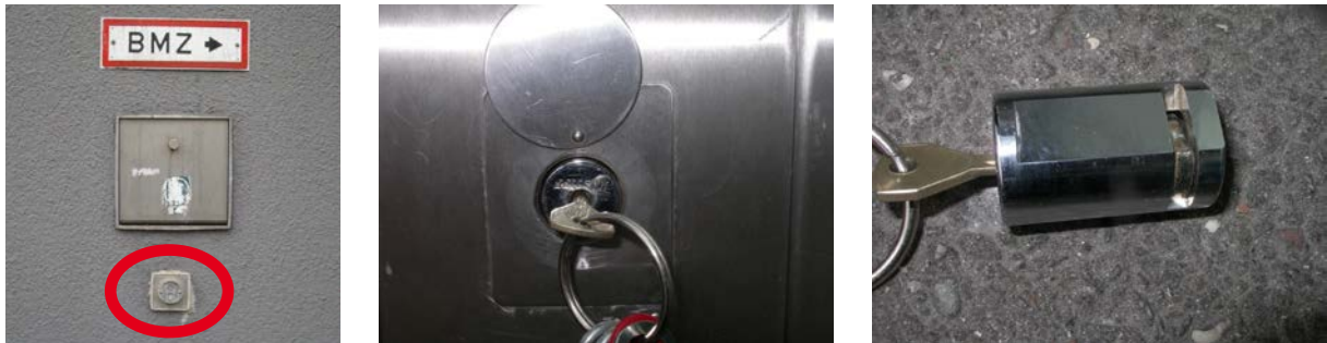
ABBILDUNG 13: LINKS: LAGE DES FSD, MITTE: GEÖFFNETE KLAPPE, RECHTS: ENTNOMMENER STAHLZYLINDER
