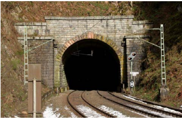
Bild 4: Südportal des Tunnels beim 4. Bauer (Badische Schwarzwaldbahn zwischen Hornberg und Triberg) (Foto: Christian Keller, Feuerwehr Wolfach)
