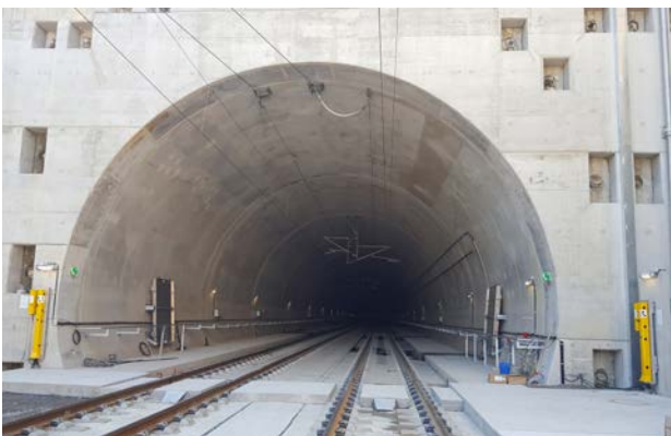
Bild 2: Nordportal des neugebauten Pforzheimer Tunnels kurz vor der Inbetriebnahme 2018 (Residenzbahn zwischen Ispringen und Pforzheim) (Foto: Feuerwehr Pforzheim)
