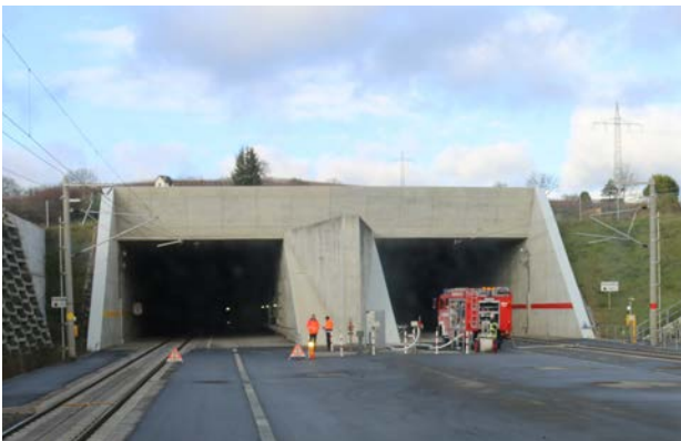
Bild 1: Südportal des Katzenbergtunnels (Oberrheinbahn zwischen Efringen-Kirchen und Bad Bellingen) (Foto: LFS)
