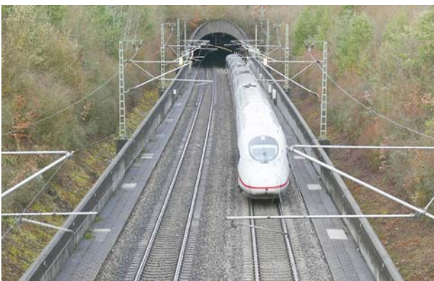
Bild 3: Südostportal des Freudensteintunnels (Foto: Jürgen Link, Regierungspräsidium Karlsruhe)
